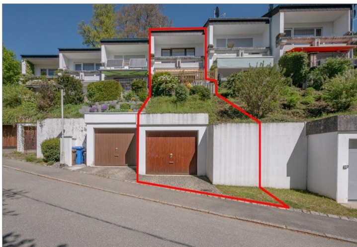
Aussenansicht mit Garage
